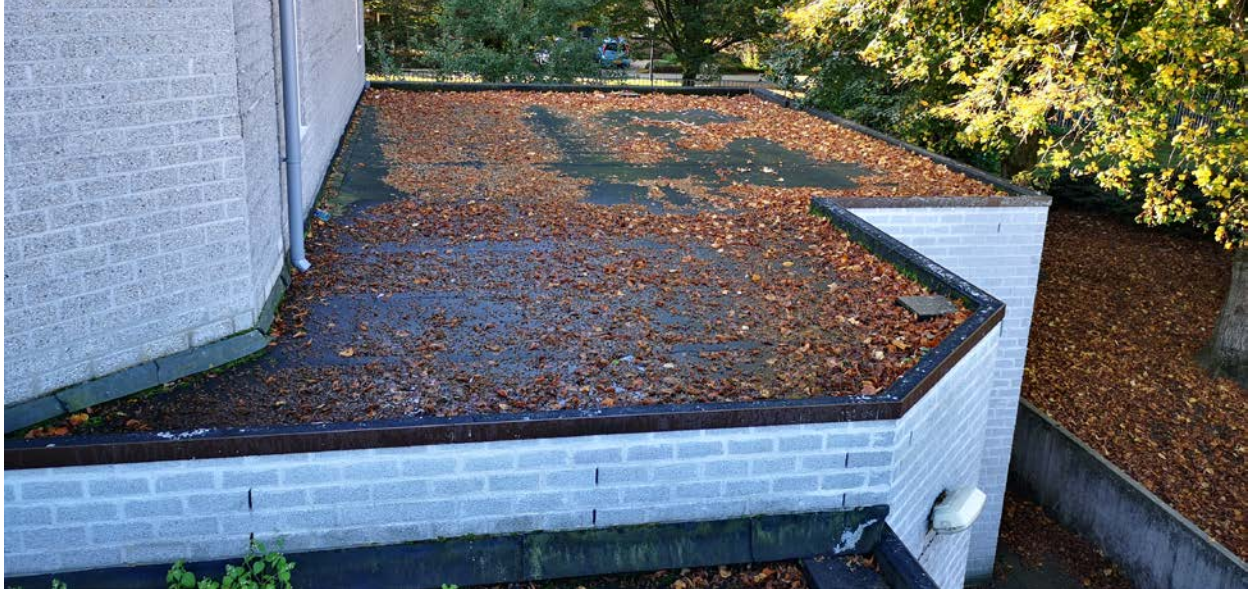
Figuur 8 | Dakvlak uitbreiding met kanaalplaatvloer, veel blad en schaduw op dit dak.
