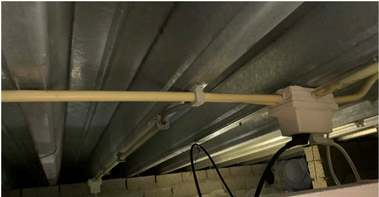
Figuur 6 / Stalen dakplaten met een hoogte van 106mm.
